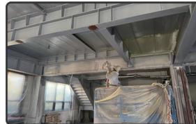
우레탄 단열공사 내화, 흡음 뽐칠 공사
