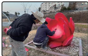
조형물 등 특수 도장 공사
