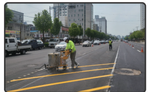
주차장, 도로, 공원 차선 도색공사
