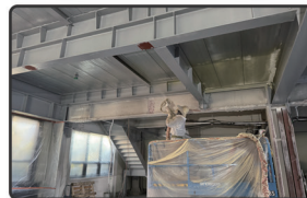
우레탄 단열공사 내화, 흡음 뽐칠 공사
